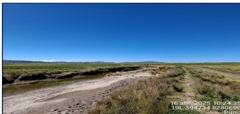
FIGURA 1 y 2 : TRAMO CRÍTICO EN EL RÍO CHICO COATA, EN EL SECTOR CARATA, DISTRITO DE COATA, PROVINCIA DE PUNO - PUNO. NOTESE, LA ACUMULACION DE MATERIAL SEDIMENTADO EN EL CAUCE, QUE REQUIERE SER ELIMINADO PARA REESTABLECER LA SECCION HIDRAULICA DE LA CAJA DEL CAUCE EN ESTE SECTOR.
